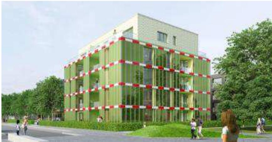
Bauausstellung (IBA) in Hamburg. Mit dem innovativen Projekt entstand in Hamburg Wilhelmsburg das erste Haus weltweit, das sich selbst über seine Fassade - bestehend aus Photobiokollektoren
